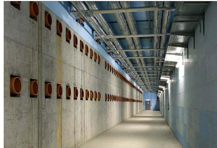
Abbildung 33: Luft-Erdwärmekollektor; Quelle: ATP
