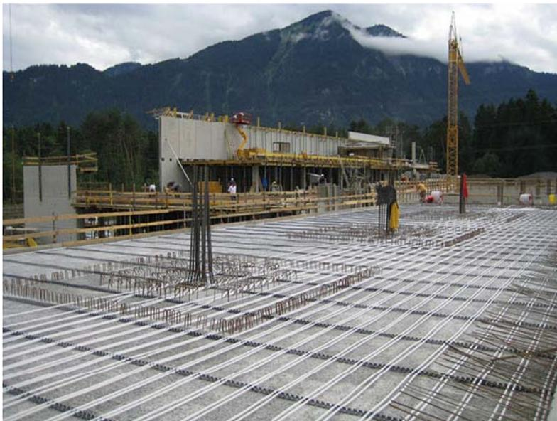
Abbildung 31: Bauteilkerntemperierung; Quelle: ATP
